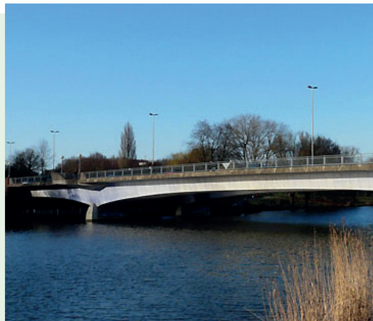
TORMINBRÜCKE, AASEE, MÜNSTER
